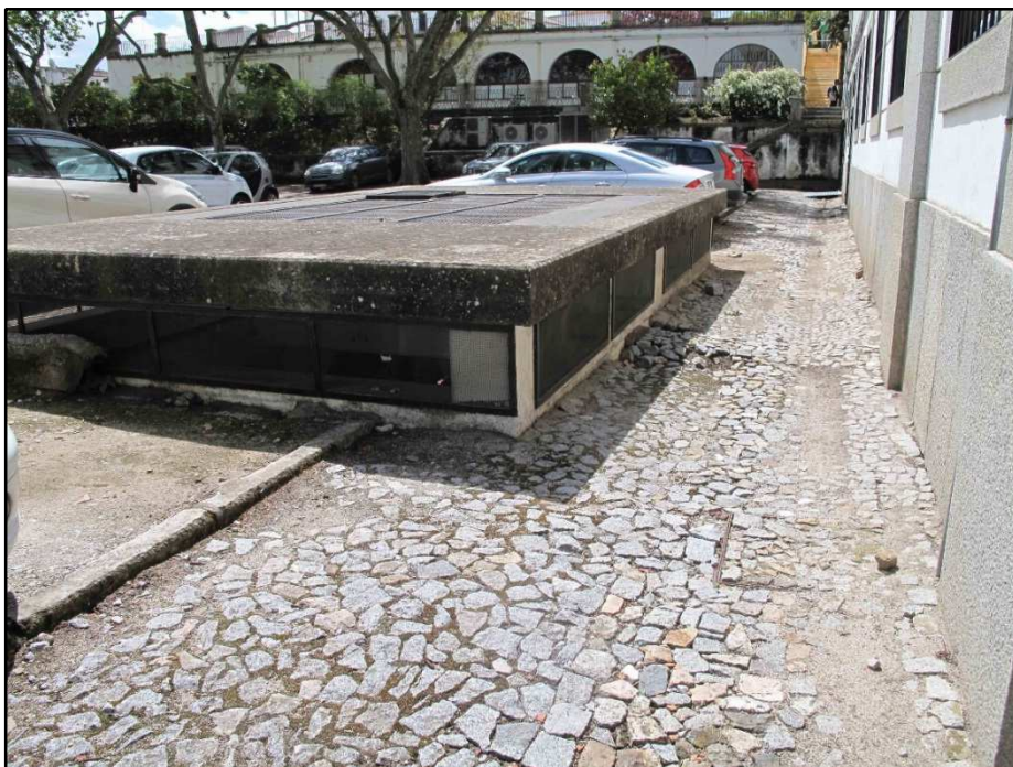
Figura 3. Infraestruturas de climatização do CES (©Leonor Rocha).
