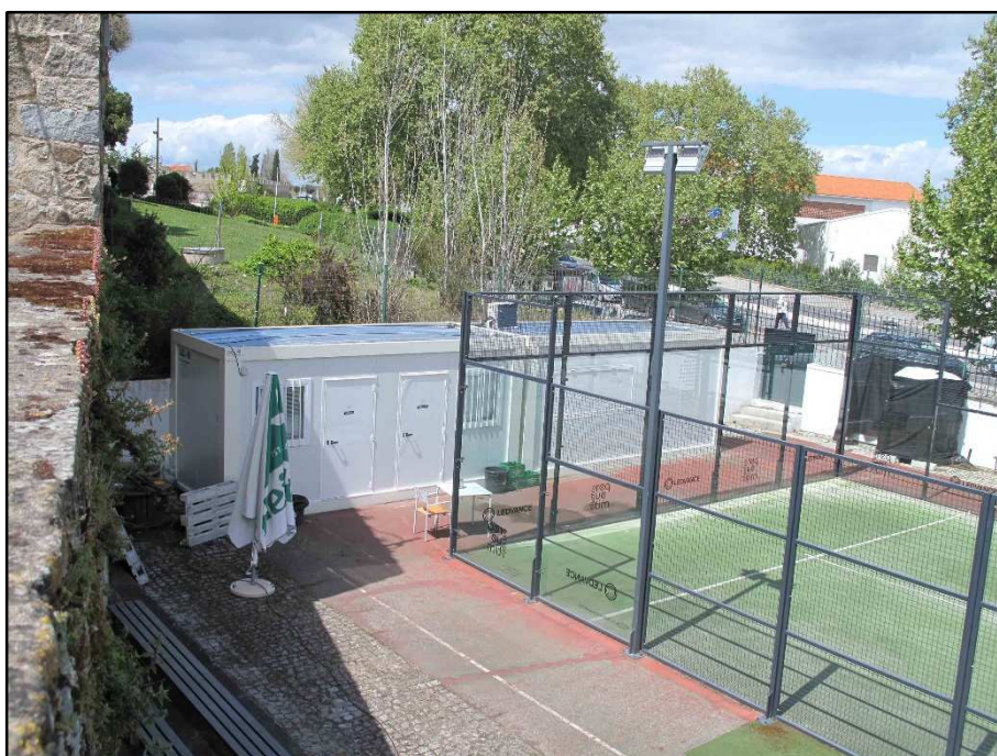
Figura 18. Vista geral das estruturas de apoio construídas nos Campos Padel. (©Leonor Rocha)
