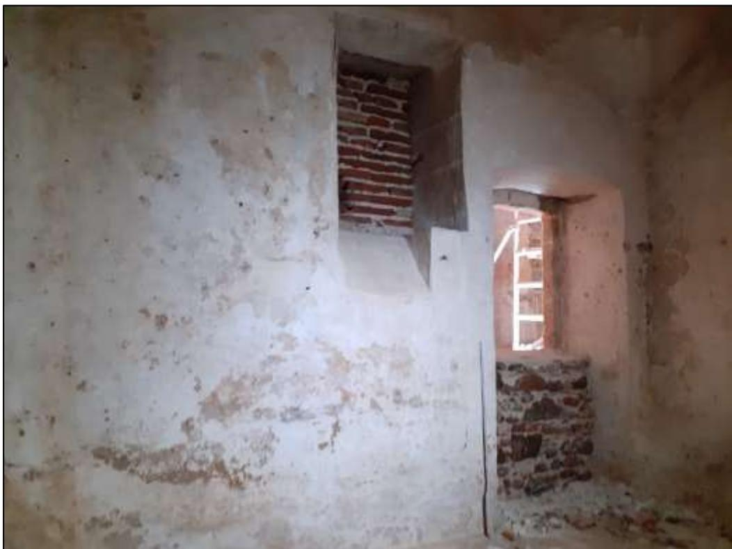
Figura 12. Parede Sul da sala [6005] com inclusão da janela e da porta, ambas seladas
