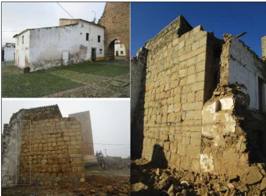
Figura 3 – Zona da intervenção de demolição na zona das Portas de Montalvão (Fotografias da autora)
