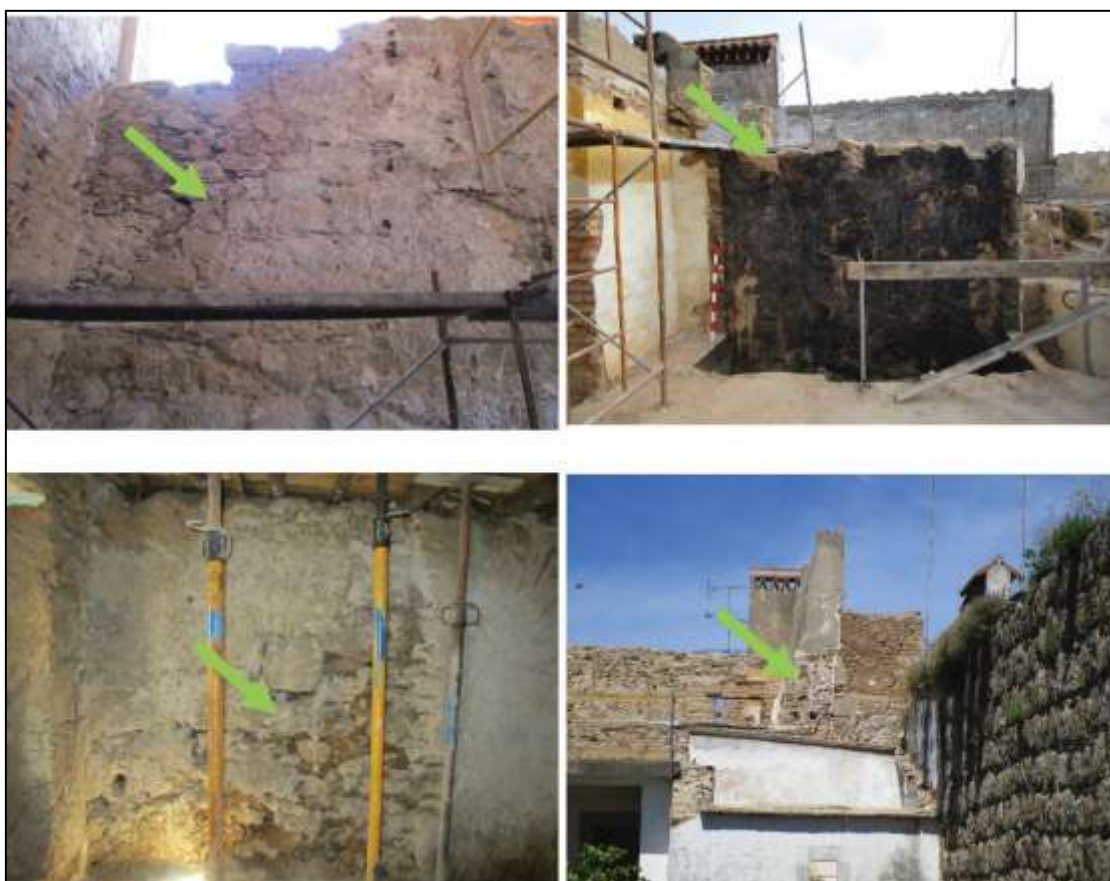
Figura 6 – Identificação das escadas de acesso á torre e ao adarve no interior da habitação e no topo e exterior do edifício, visto da Torre das Portas de Montalvão (Fotografias da autora)
