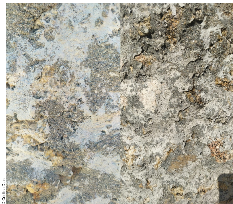
Figura 2 – Zona de consolidação entre os dois blocos de granito. A superfície voltada a Sul apresenta mais destacamentos e perda de material do que a zona voltada a Norte. A superfície do geopolímero, bem como todo o menir apresentam biocolonização (manchas acastanhadas)
