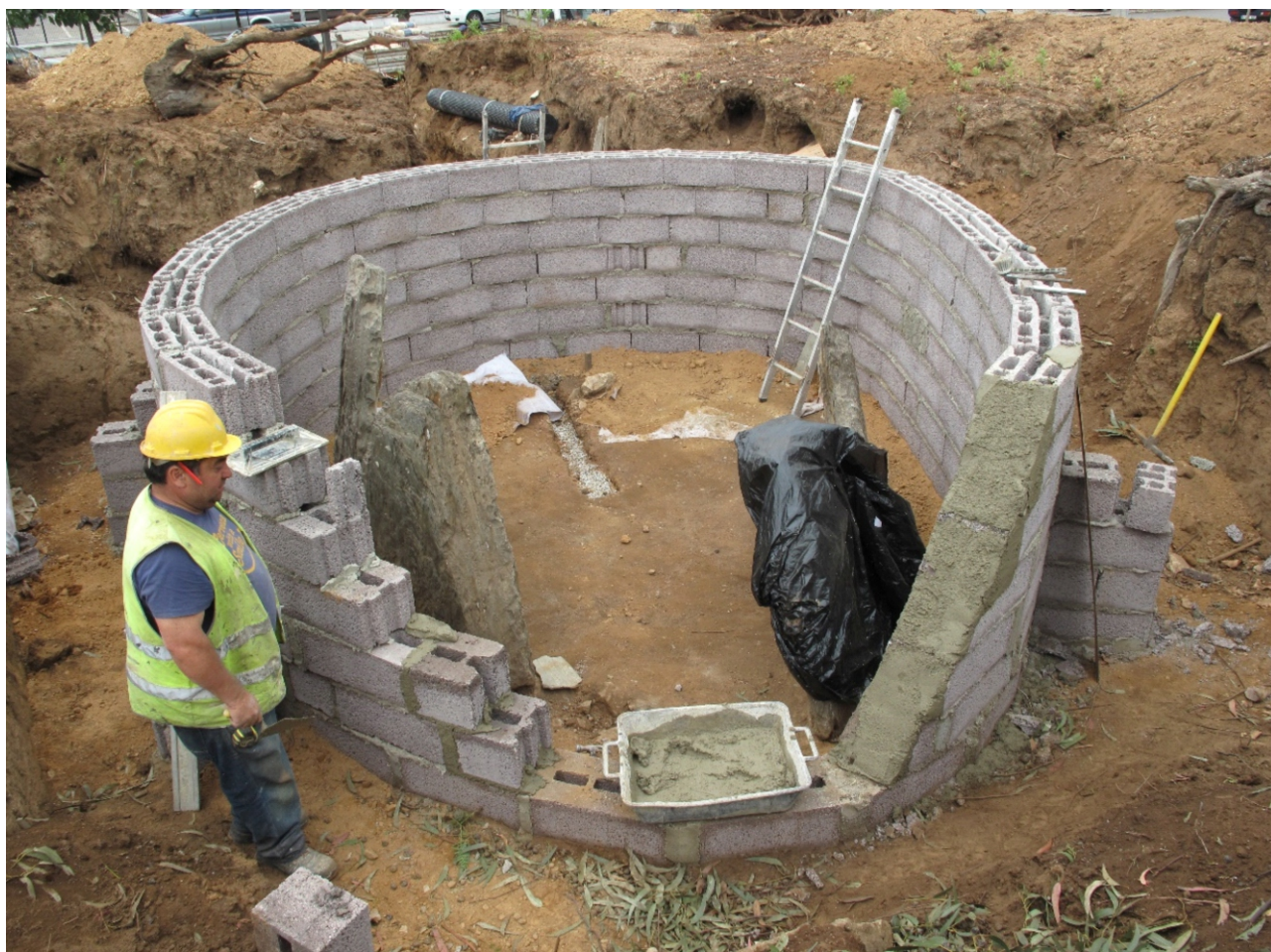
Figura 4 – Mamoas 1 do Taco durante os trabalhos de restauro (©Branco, 2015)
