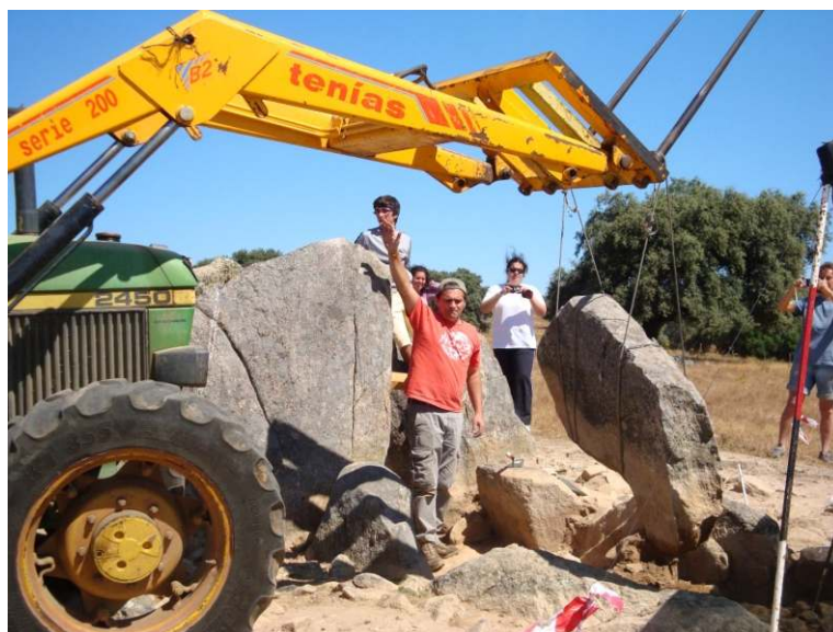
Figura 32. Remoção mecânica das tampas tombadas dentro do corredor
