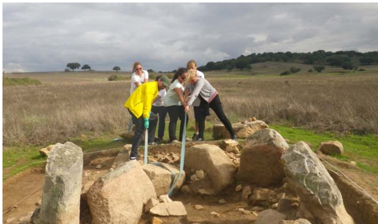
Figura 27. Pormenor dos trabalhos de recuperação realizados
