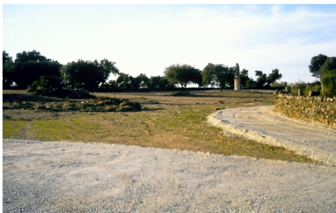
Figura 7 – Fase da construção do acesso pedonal (18 Dezembro 2001)
