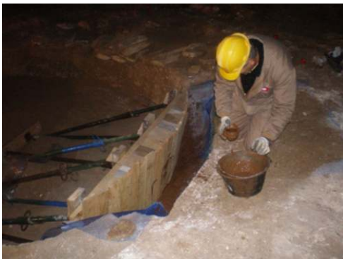
Construyendo el tapial
