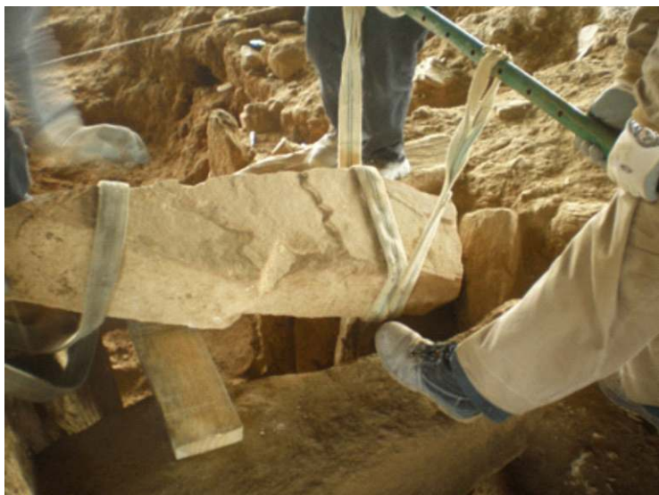
Colocación del dintel
