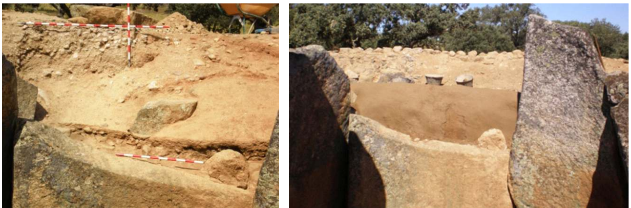
Creación de un muro de contención en la zona de la C4
