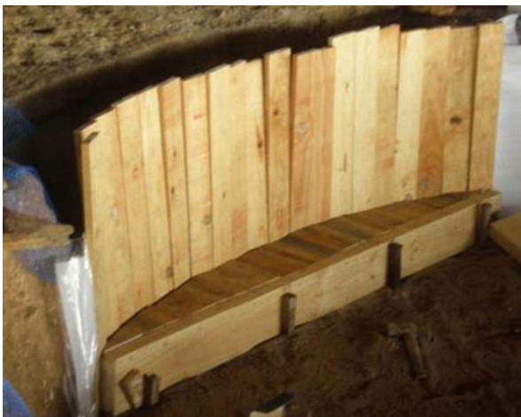
Construyendo el tapial
