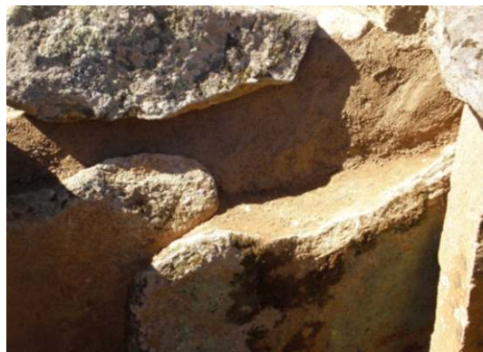
Muro en el lateral de la primera antecámara
