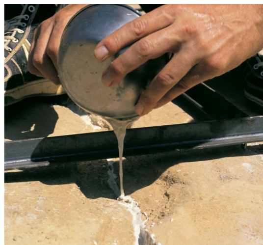
Fig. 04 – Alcalar 7, colagem do lintel de cobertura do nicho norte, com armação metálica de suporte Foto: M. Ribeiro, 1988.
