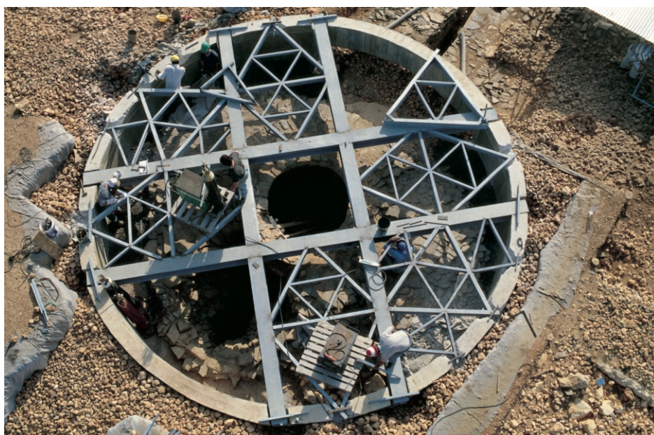
Fig. 05 – Alcalar 7, construção da estrutura de suporte da recomposição da mamoa. Foto: R. Parreira, 2000.
