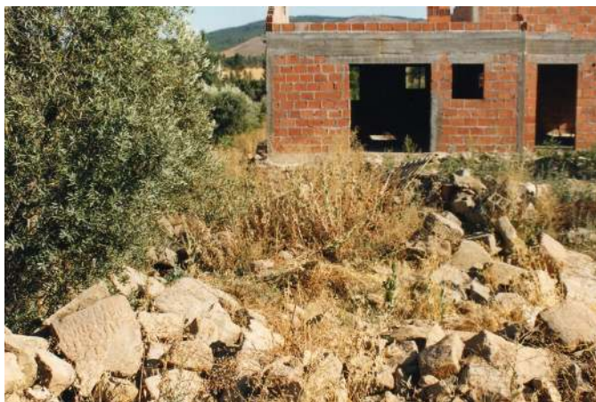
Figura 5. Entulho de casa em construção.
