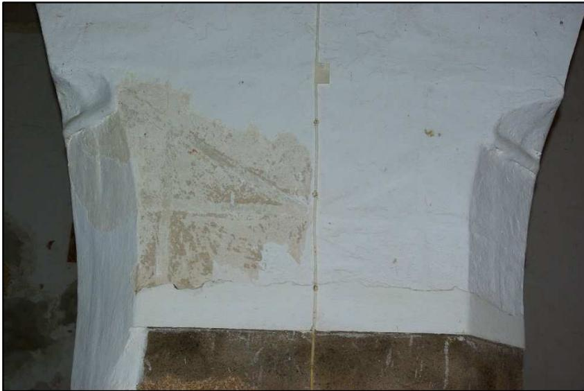
Figura 34 – Aplicação da técnica de esgrafito
