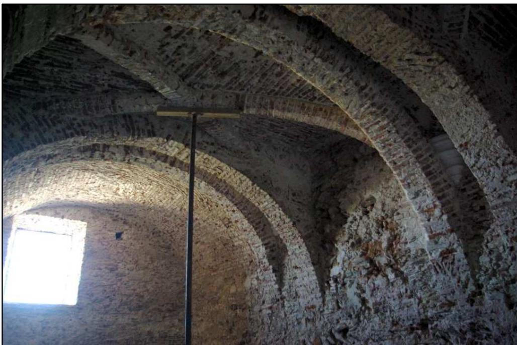
Figura 21 – Soluções construtivas registadas ao nível dos tectos
