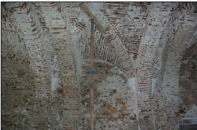
Figura 20 – Pormenor da sobreposição das estruturas do tecto
