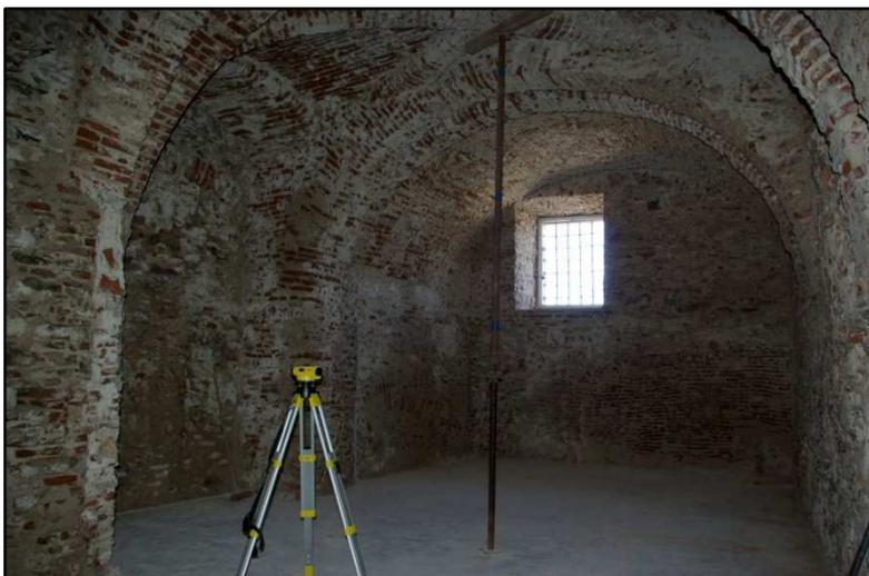
Figura 16 – Aspecto geral do espaço após a remoção de rebocos
