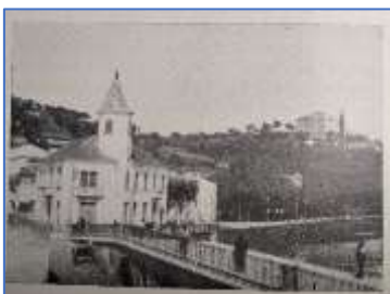
Figura 4: Fotografia da Ermida de Nossa Senhora da Conceição (no alto), com a Casa Vieira em destaque.
