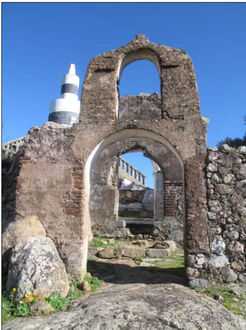
Castelo de Cabeço de Vide (Alter do Chão). 2020
