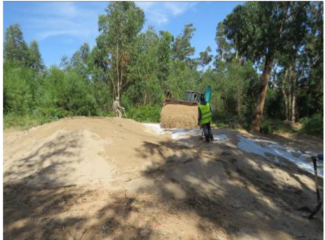
Fotografia 36: Cobertura do forno com geotêxtil. Fotografia 37: Início de enchimento da câmara com areia. Fotografia 38: Decorrer dos trabalhos de cobertura. Fotografia 39: Decorrer dos trabalhos de cobertura.
