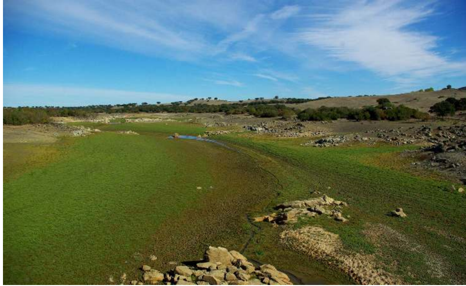
Figura 4. Vista geral do Complexo do Pedrogão
