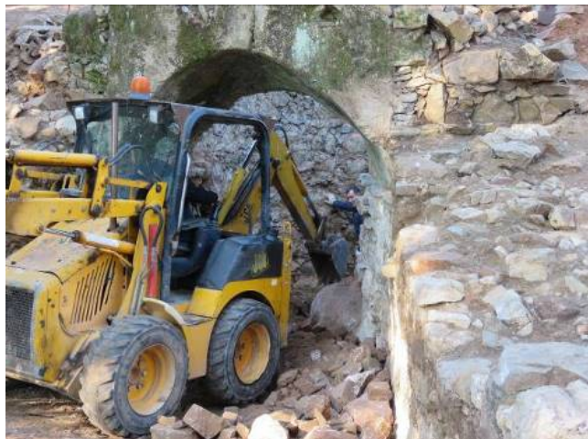
Fotografia 9: Máquina JCB 1CX, a executar a desobstrução da câmara a partir da entrada.
