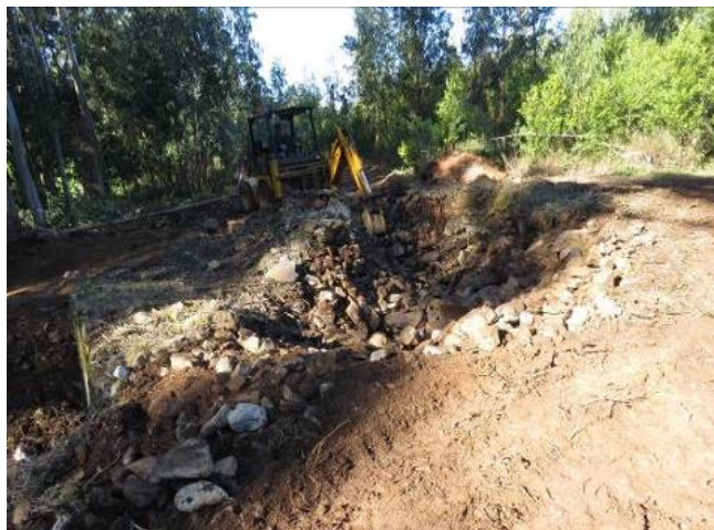
Fotografia 7: Início da desobstrução da câmara a partir do topo da câmara.
