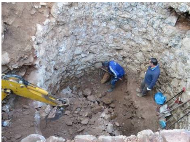
Fotografia 7: Início da desobstrução da câmara a partir do topo da câmara.
